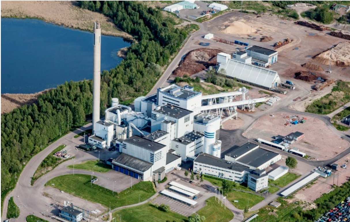
Figur 12 Foto Karlstads Energi
